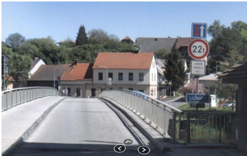
Čelkovický most přes řeku Lužnici (omezená zatížitelnost)
